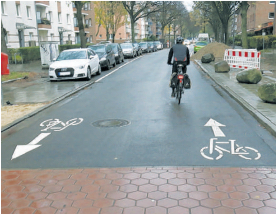
Der Horner Weg wird zur Fahrradstraße ausgebaut: Fahrräder haben Vorrang. Dass dort Tempo 30 gilt, ist für Autofahrer nicht erkennbar, teilweise fehlt eine Beschilderung Foto: Timm
