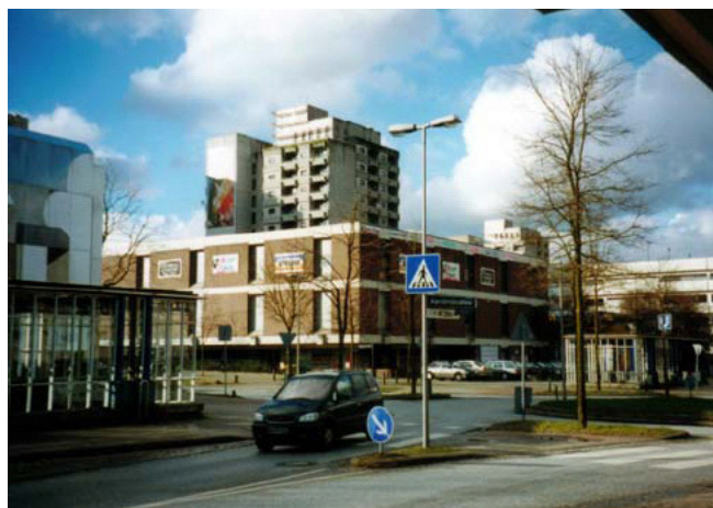
Kaufhaus im alten Zentrum Seit 2007 steht das Zentrum erneut unter Zwangsverwaltung
